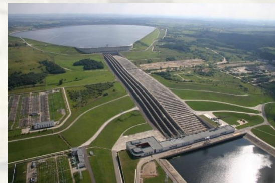
Kruonio hidroakumuliacinė elektrinė, Kruonis
